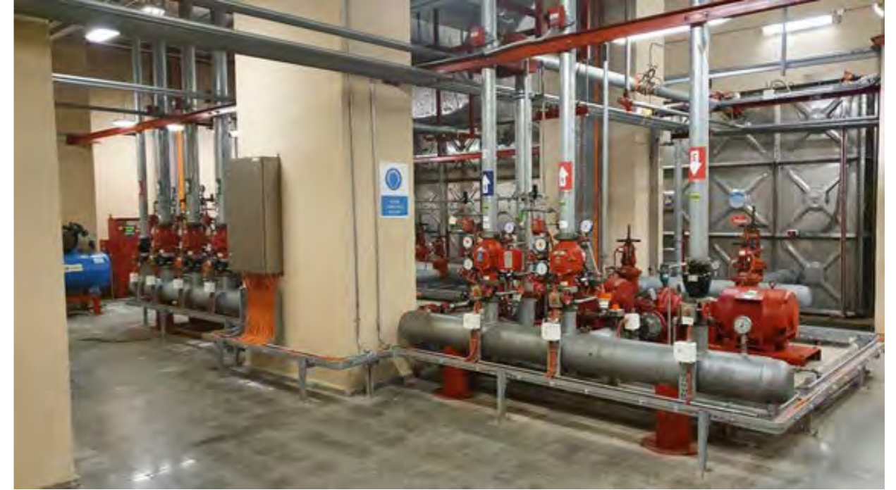
Yangın pompa Odası genel Görünümü
