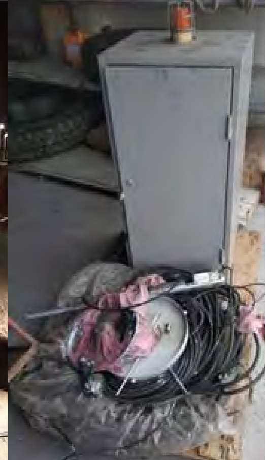
Hy - Power Yağlama Pompalarının Devreye Alınması
